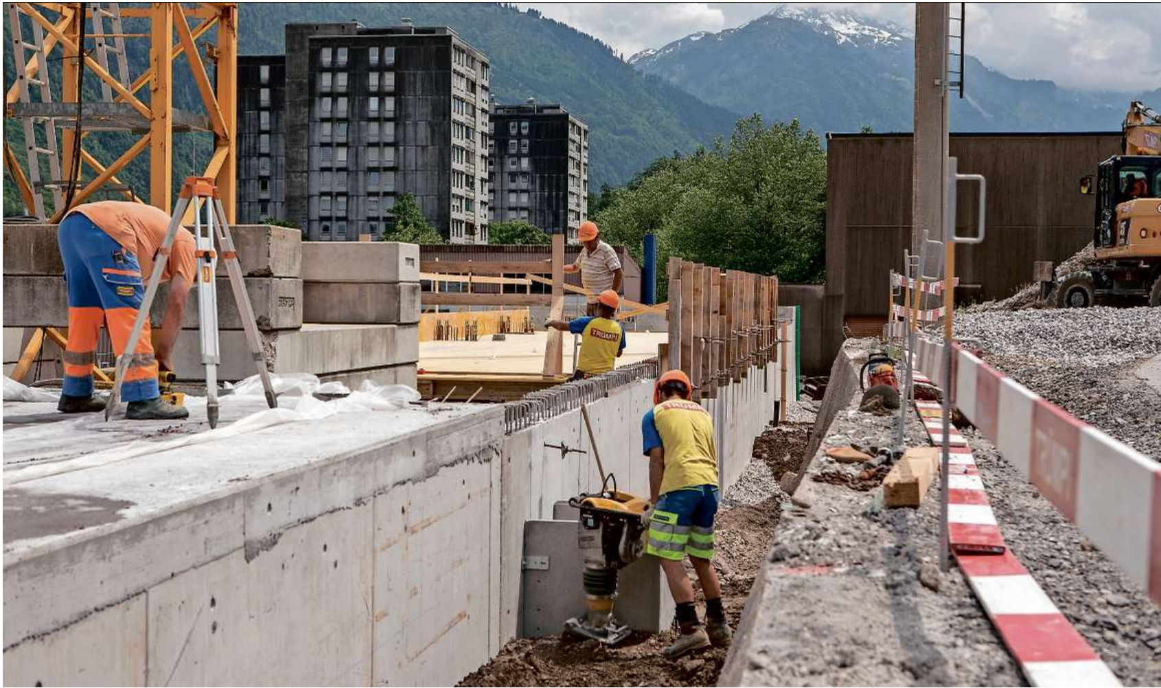
Bauen an der Infrastruktur: Die Gemeinden investieren vermehrt – im Bild die inzwischen erweiterten und erneuerten Sportanlagen Buchholz in Glarus.
