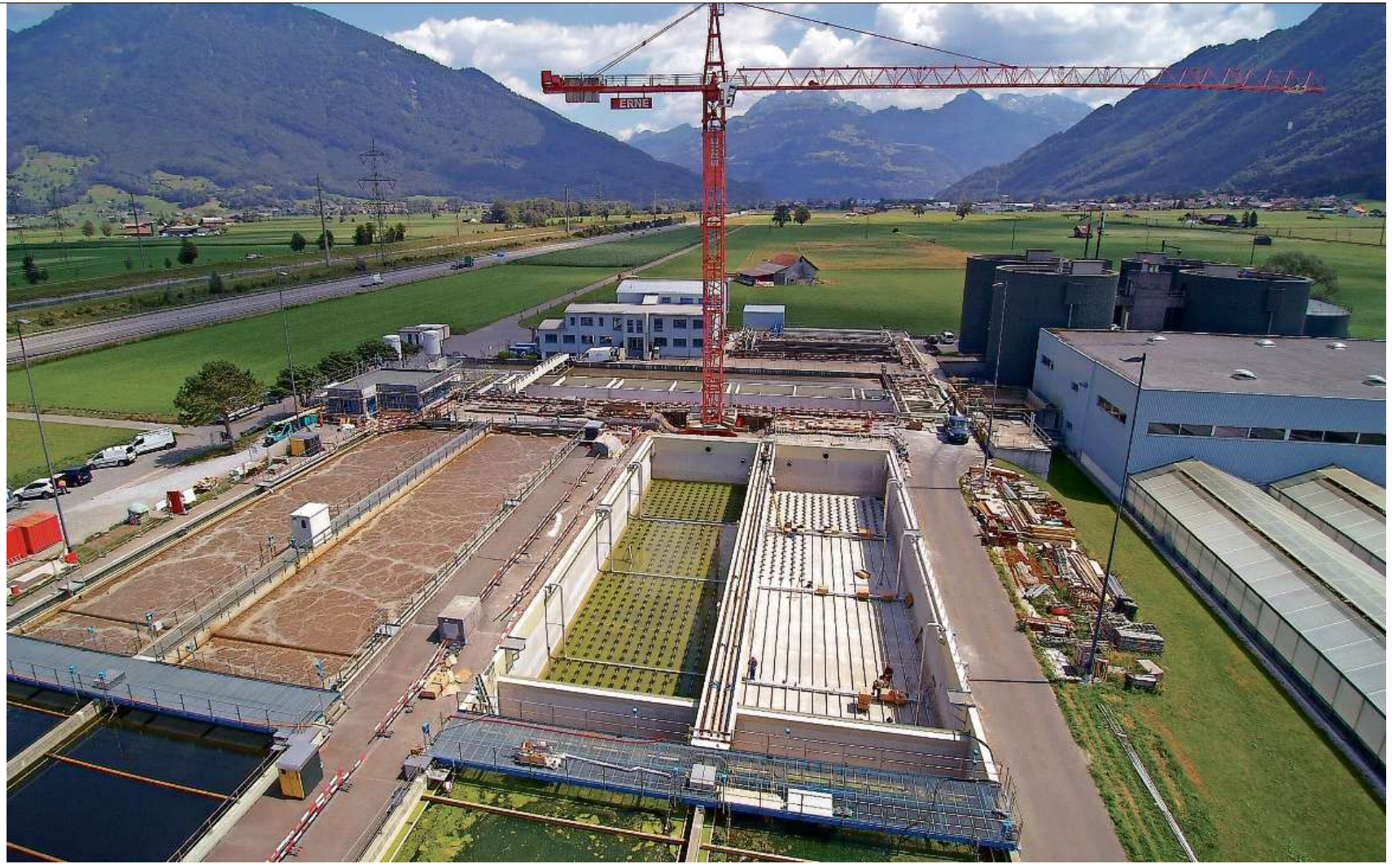
Vogelperspektive: Nur von weit oben ist das Ausmass der Grossbaustelle auf der ARA Bilten zu erahnen.
