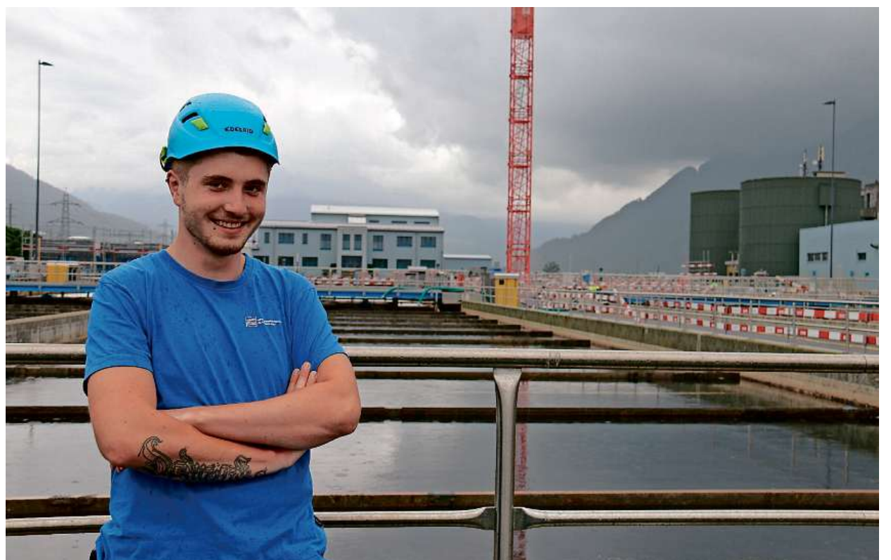
Hygiene-Vorschriften und Schutz: Louis Schmid zieht jeden Tag vor Ort seine Berufskleider an. Seit einem Jahr gehört zur Montur auch ein Helm – dies aus Sicherheits-Gründen rund um die Bauarbeiten auf der Kläranlage.
